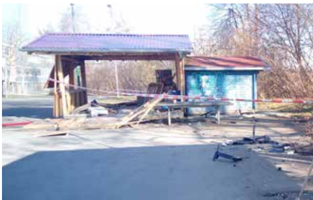
Keinen schönen Anblick bot die beschädigte und dann abgerissene Hütte am Skateplatz Ende Februar. Erst im vergangenen Jahr wurde diese Hütte von der Stadt Isny renoviert. Der Verein Kinder- und Jugendarbeit beteiligte sich an den Kosten. Die Mobile Jugendarbeit hat die Hütte mit Jugendlichen erst im letzten Sommer gestrichen.
